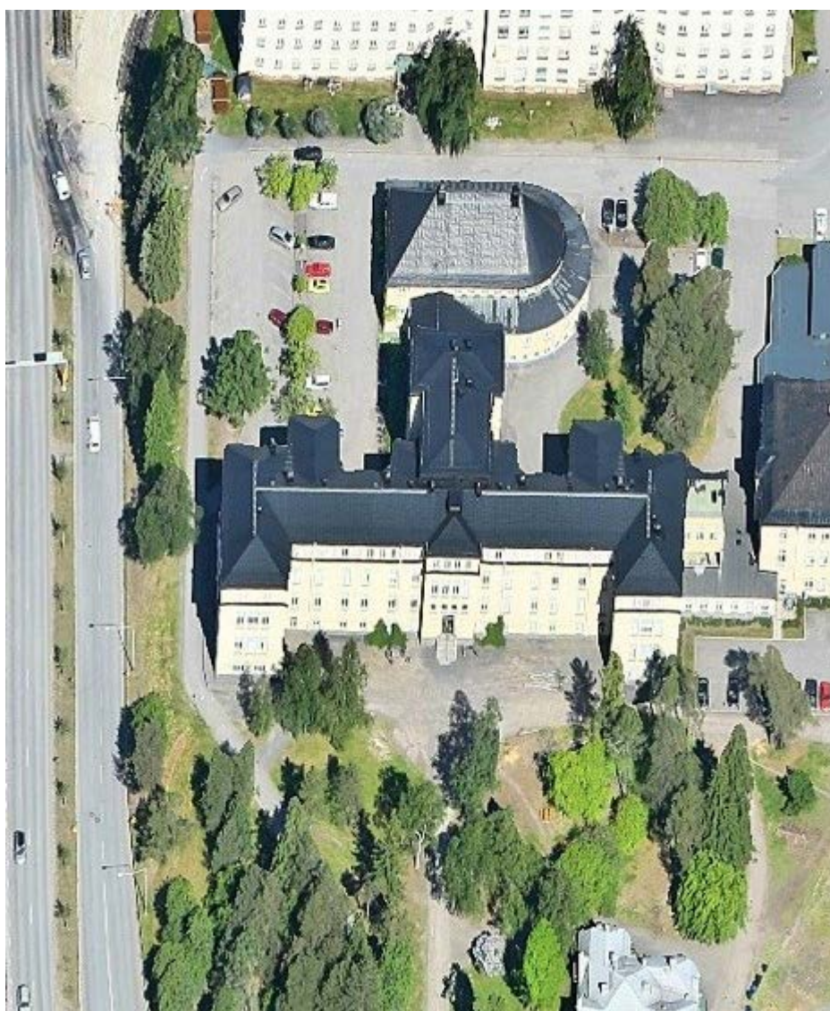
Länslasarettetsbyggnaden uppförd i tre etapper. Axel Kumlien 1903-07, Ernst Stenhammar 1918-21, och Gustaf Birch Lindgren 1935-39.
