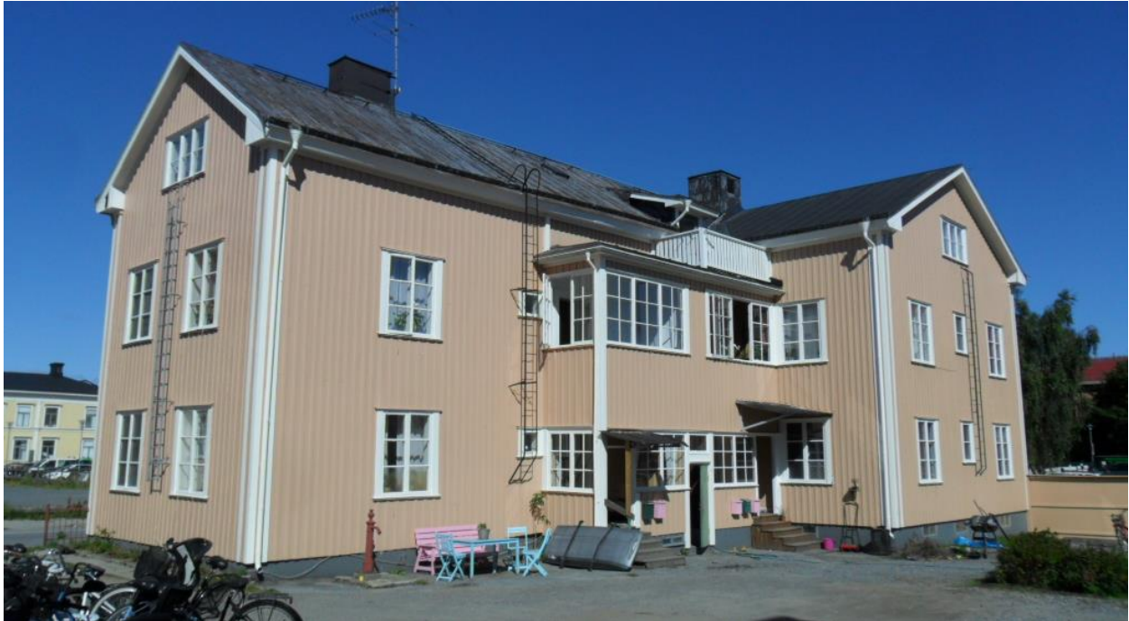
Foto från före förtätning och renovering då bland annat den röda vattenposten av 1870-talstyp, en av stadens sista kvarvarande, kastades bort.
