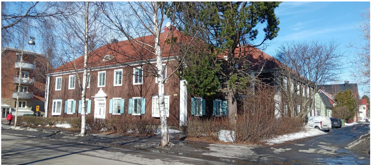
Ekholtzka huset (1919, tillbyggt åt norr 1921) ritat av Erik Karlstrand (1885-1967) för den kända fotograffamiljen. Flera deltagare menade att föreningen borde anmäla det allt värre förfallet till
