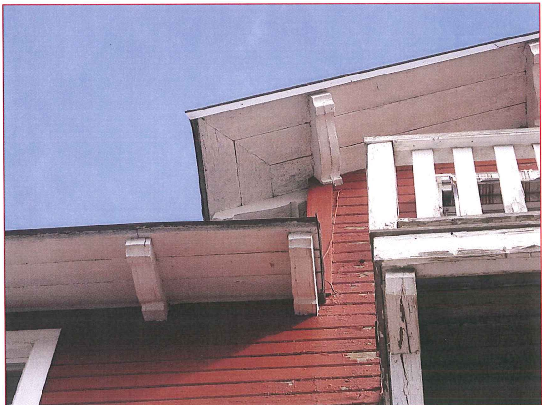
Ett antal taktassar demonteras och återanvänds.
